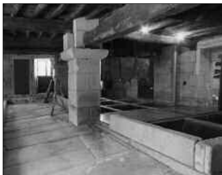
Antiga fábrica de curtidos rehabilitada como Pousada.
